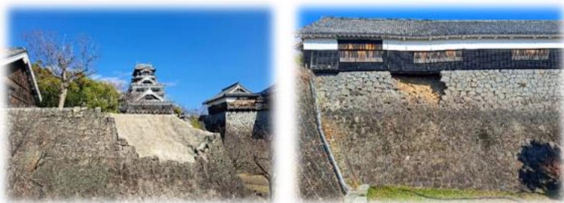
今回の学会にて撮影 崩れたままの石垣から地震の凄まじさが伝わってきました
